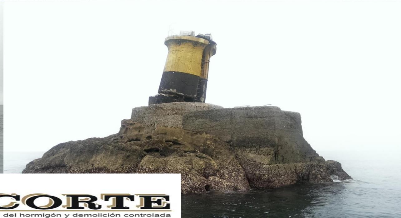
LA RETIRADA DEL FARO SE EJECUTA MEDIANTE GATOS HIDRAULICOS, QUE LEVANTARON TODA LA PIEZA HASTA DEPOSITARLO EN EL MAR, PARA SU TRASLADO A TIERRA.
