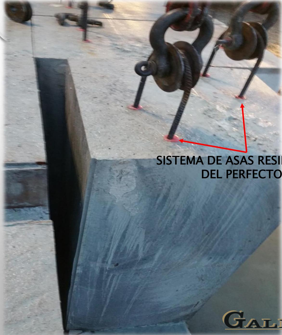
**SISTEMA DE ASAS RESINADAS PARA IZADO Y VISTA DEL PERFECTO CORTE EFECTUADO**
